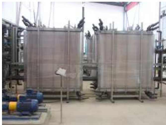
Pilas de electrodiálisis de Puerto del Rosario
