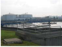
EDAR COPER (SEVILLA)
